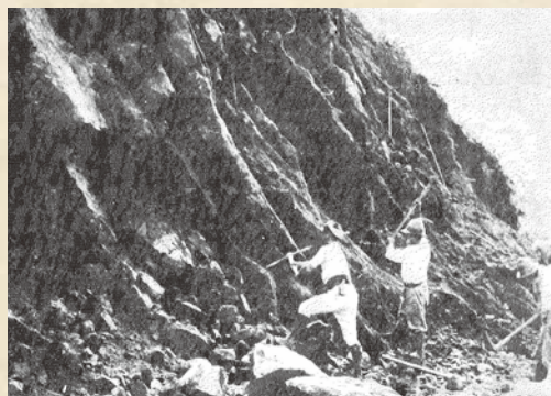
張碓隧道付近(昭和9年「札幌国道写真帳」より)
